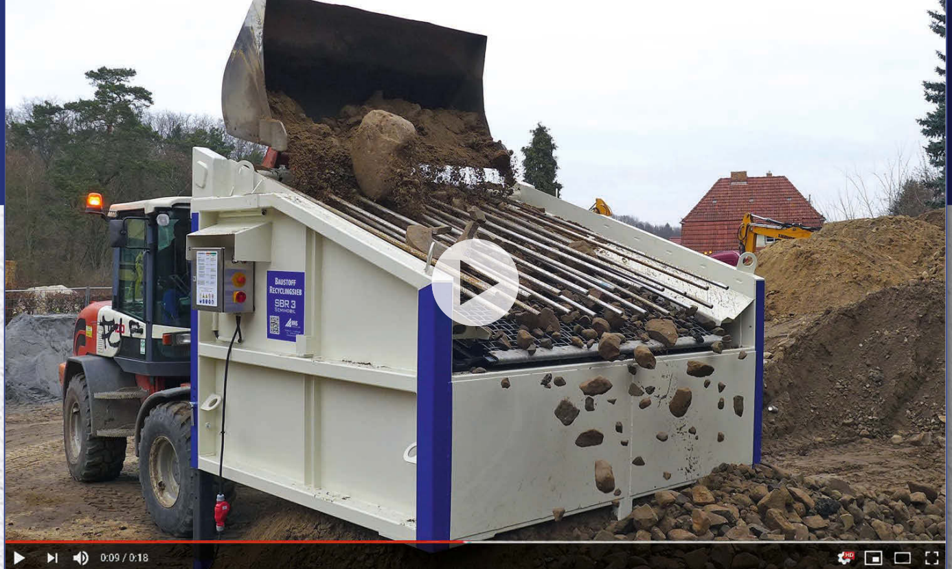
Recycling im Straßen- und Tiefbau mit Grobstücksiebzanlage SBR 3
